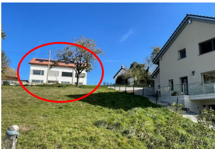
Figure 6 : Photo prise sur le terrain (16.10.23) du bâtiment sur la parcelle n°566
